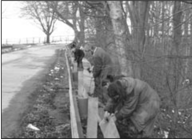
Stavba zábran u Českého Šternberka.
