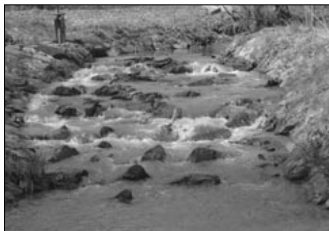
Úpravy koryta na Račím potoce.
