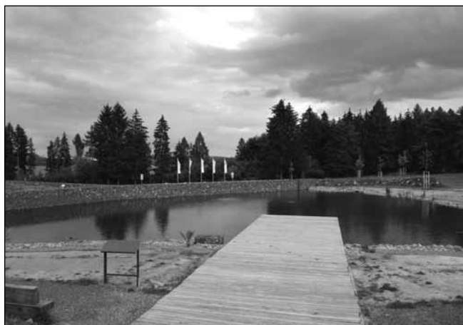
Expoziční jezírko u Vodního domu bylo v roce 2017 opraveno, napuštěno a zarybněno.
