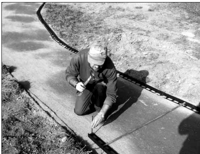
Budování mlatové cesty v Ratměřicích.
