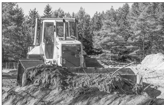
Strhávání vrchní vrstvy humusu pomocí těžké techniky.
