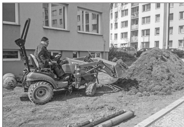
Zemní práce ulice Zapova Benešov.
